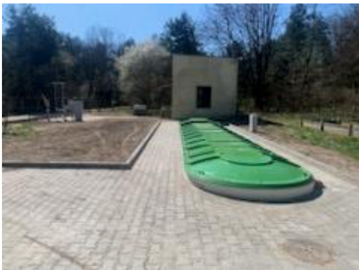
Złoże tarczowe zmodernizowanej oczyszczalni ścieków DPS Przatówek.
